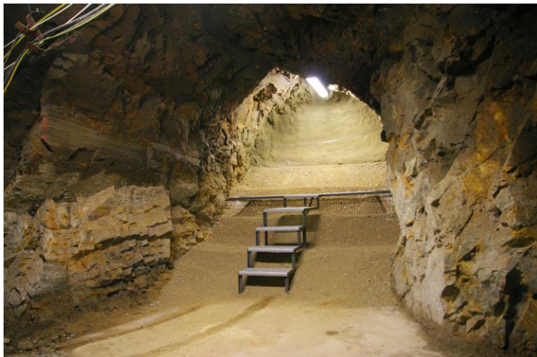
ČVUT 2007 Technologie střihaného backfillu (SÚRAO)
